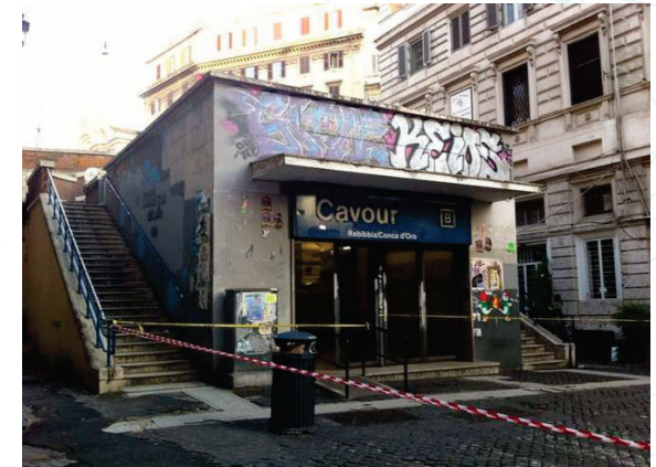
Stazione ferroviaria Roma
